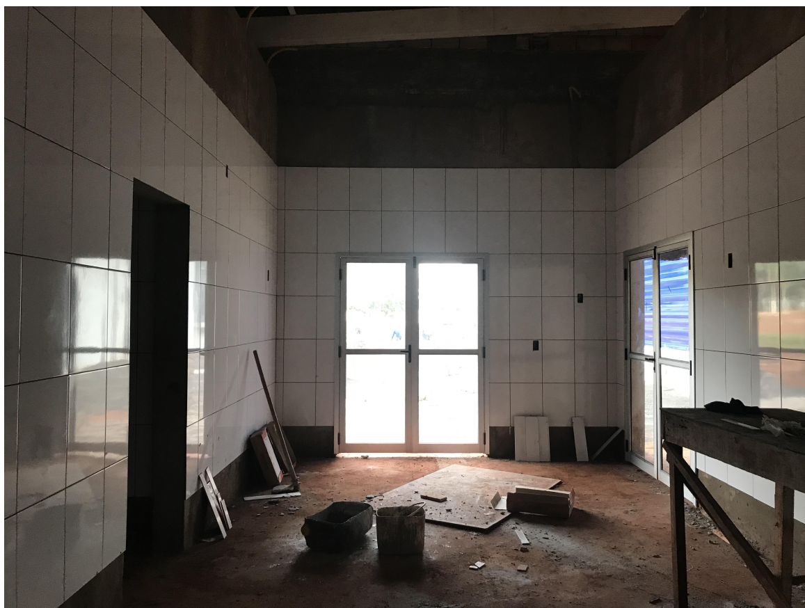
FIGURA 14 – HALL DE SERVIÇO
