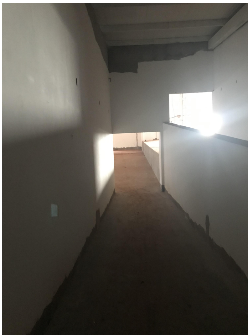
FIGURA 06 – RAMPA DE ACESSO AO PALCO
