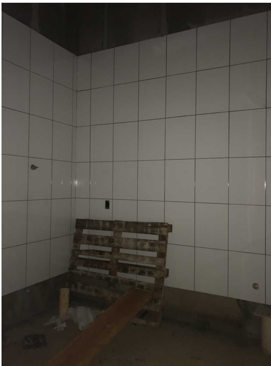
FIGURA 08 – SANITÁRIO PÚBLICO MASCULINO
